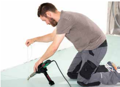
ermüdungsfreies Handschweissen von Fugen
