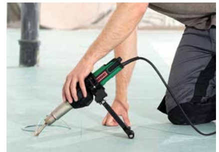
konstante Vorwärmung der Fuge
