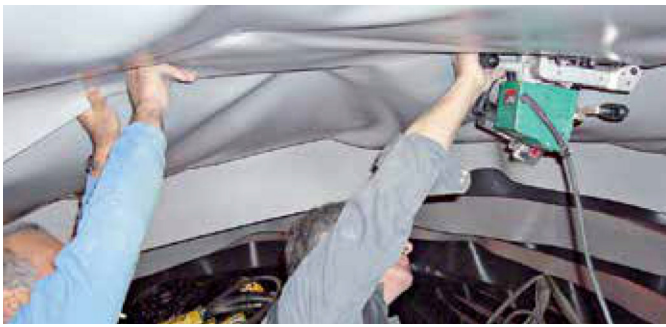
Der COMET im Tunnelleinsatz ...
