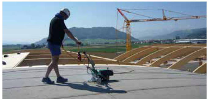
Einfache Geräteführung und sauberes Arbeiten mit dem BITUMAT B2.
